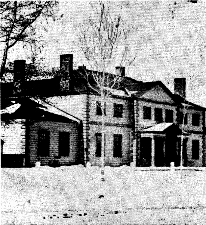
Province Hall en 1802. Cet édifice fut la proie des flammes en février 1880. (Archives provinciales du Nouveau-Brunswick)
