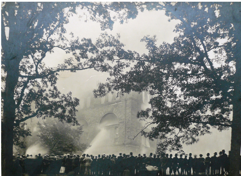
Des centaines de personnes sont venues regarder l'incendie en 1909. Des boyaux d'arrosage visaient les fenêtres de la bibliothèque de l'Assemblée législative. La photo a été prise de l'autre côté de la rue, là où se trouve aujourd'hui le Canadiana Building, du côté ouest de Queen's Park Crescent.
