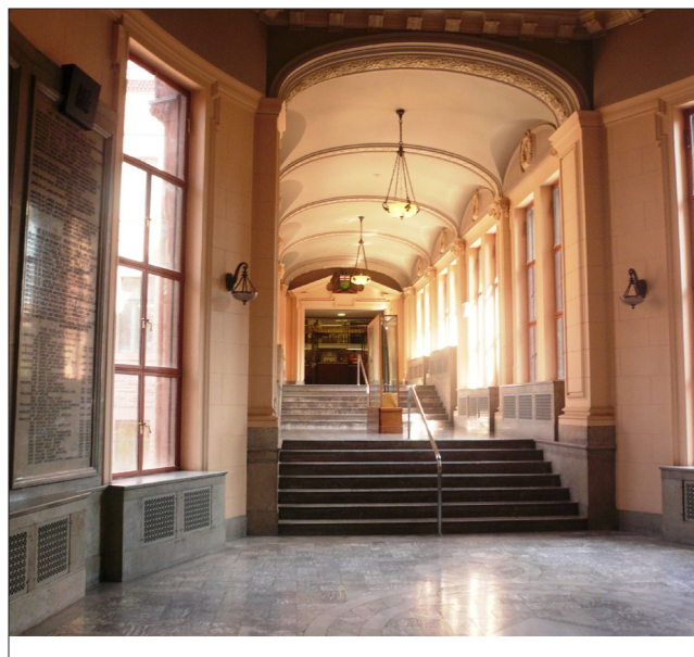
Parmi les principaux éléments visant à rendre la bibliothèque résistante au feu, notons le rayonnage d'acier, les meubles métalliques, les planchers de marbre et les balustrades en cuivre et en acier. Un long corridor, que l'on peut voir ci-dessus, sépare l'aile nord de l'édifice principal et se termine aux deux extrémités par des portes coupe-feu.
